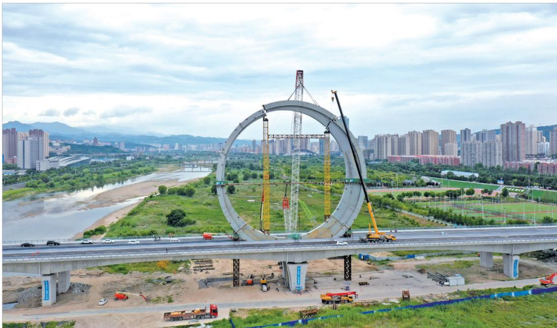
本报讯 6月21日下午，宝鸡渭河团结大桥中央“日月同辉”造型的最后一个钢构件完成吊装，整个造型顺利合龙(见左图)。
