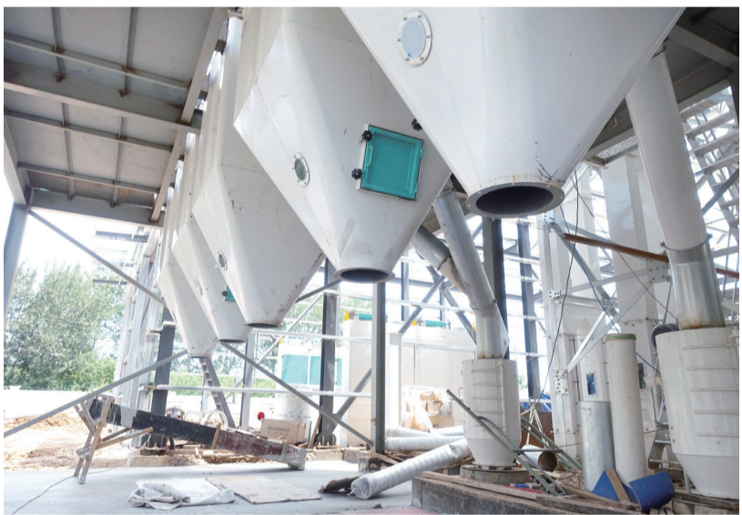
出料设备正在安装中
